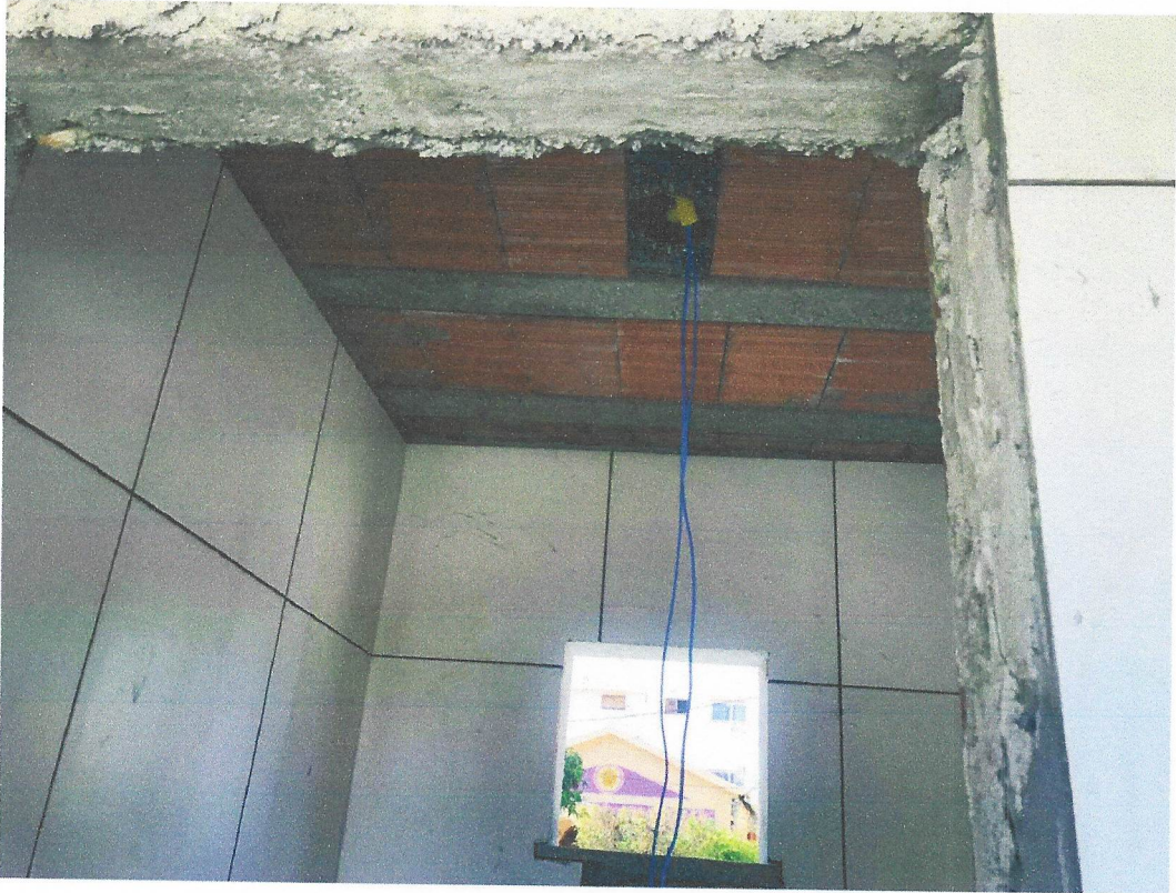
Foto 03- CABO DE COBRE FLEXÍVEL ISOLADO, 2,5 MM 2 , ANTI-CHAMA 450/750 V, PARA CIRCUITOS TERMINAIS - FORNECIMENTO E INSTALAÇÃO. AF_12/2015
