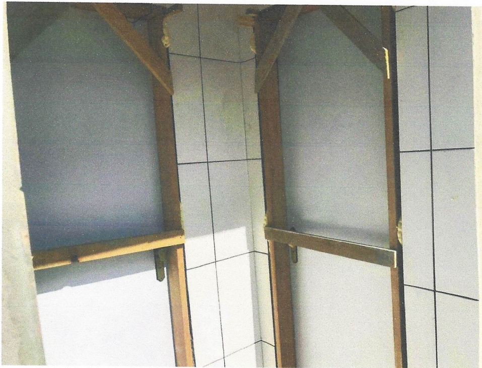
Foto 11 – KIT DE PORTA-PRONTA DE MADEIRA EM ACABAMENTO MELAMÍNICO BRANCO, FOLHA LEVE OU MÉDIA, E BATENTE METÁLICO, 60X210CM, FIXAÇÃO COM ARGAMASSA - FORNECIMENTO E INSTALAÇÃO. AF_12/2019
