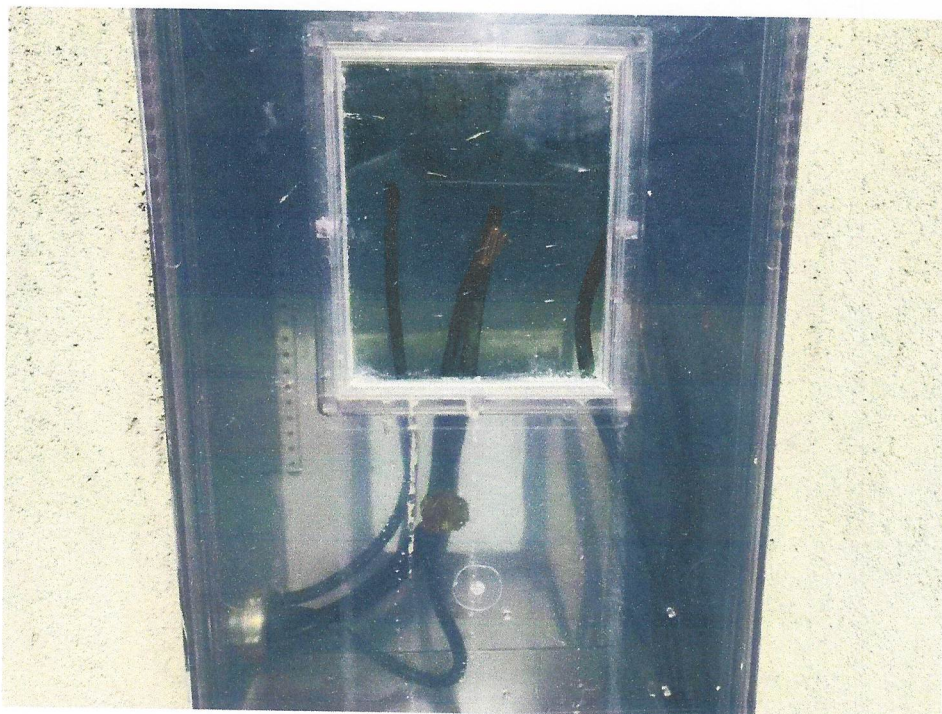
Foto 04 – CABO DE COBRE FLEXÍVEL ISOLADO, 6 MM 2 , ANTI-CHAMA 450/750 V, PARA CIRCUITOS TERMINAIS - FORNECIMENTO E INSTALAÇÃO. AF_12/2015
