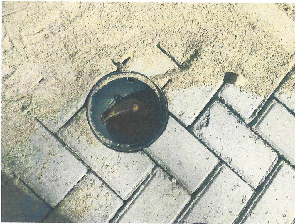
Foto 07- CAIXA DE INSPEÇÃO PARA ATERRAMENTO, CIRCULAR, EM POLIETILENO, DIÂMETRO INTERNO = 0,3 M. AF_12/2020
