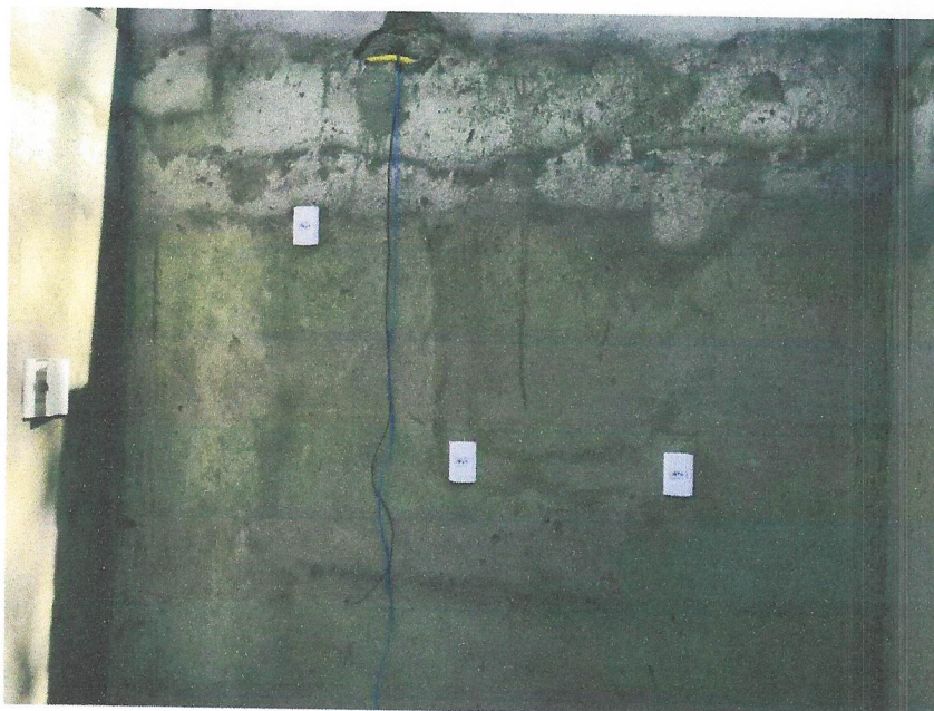
Foto 10 – TOMADA ALTA DE EMBUTIR (1 MÓDULO), 2P+T 10 A, SEM SUPORTE E SEM PLACA - FORNECIMENTO E INSTALAÇÃO. AF_12/2015
