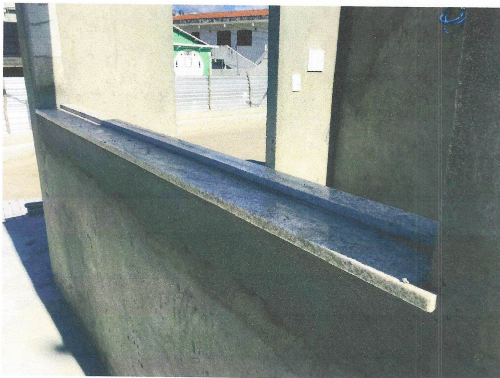
Foto 12 – Peitoril em granito branco siena, polido, c/ largura = 22 cm, esp = 2 cm
