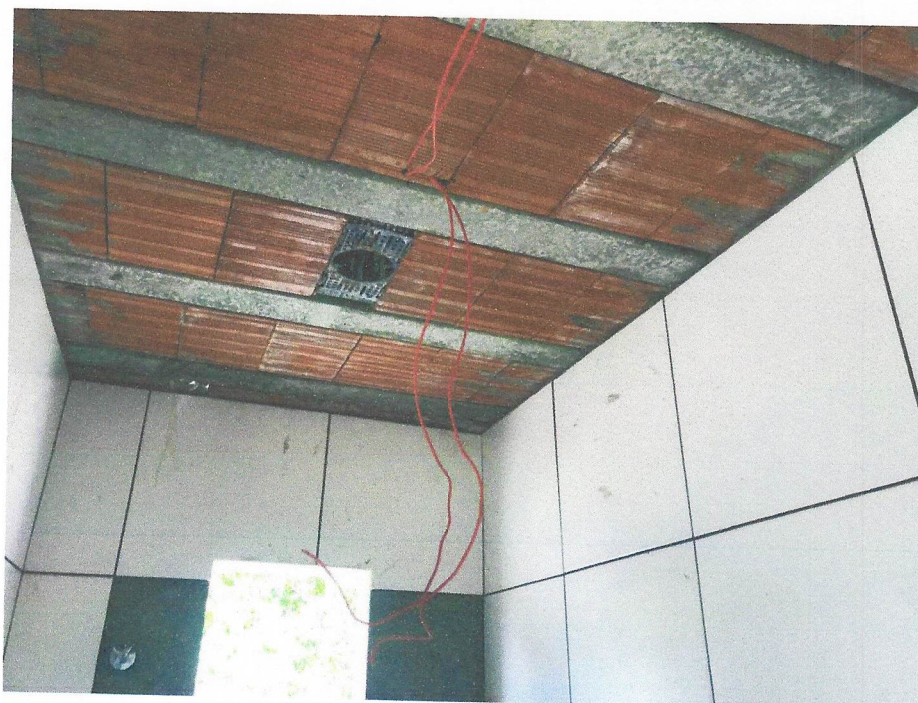
Foto 02 – CABO DE COBRE FLEXÍVEL ISOLADO, 1,5 MM 2 , ANTI-CHAMA 450/750 V, PARA CIRCUITOS TERMINAIS - FORNECIMENTO E INSTALAÇÃO. AF_12/2015
