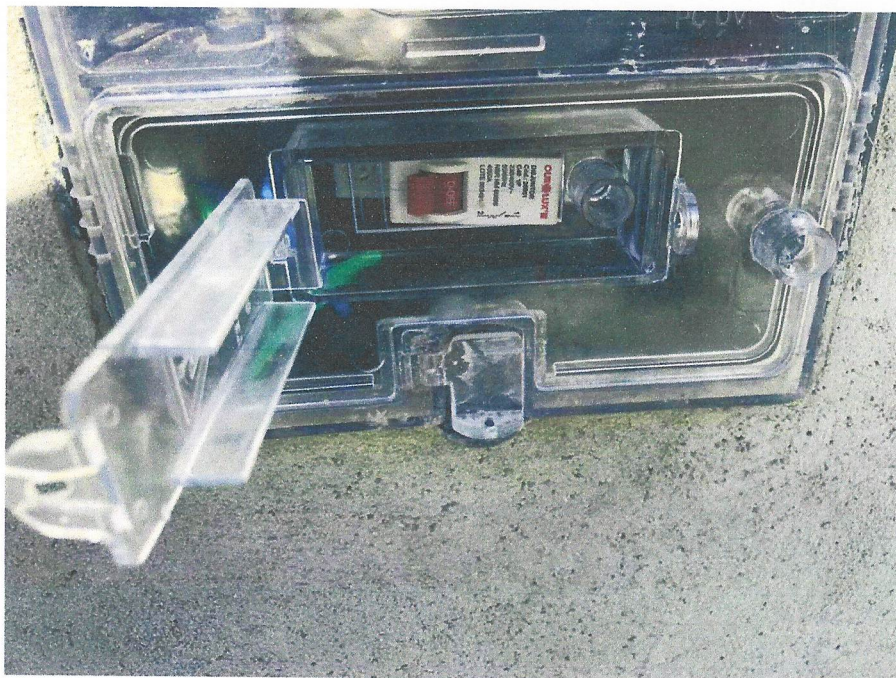
Foto 08- DISJUNTOR BIPOLAR TIPO DIN, CORRENTE NOMINAL DE 40A - FORNECIMENTO E INSTALAÇÃO. AF_10/2020
