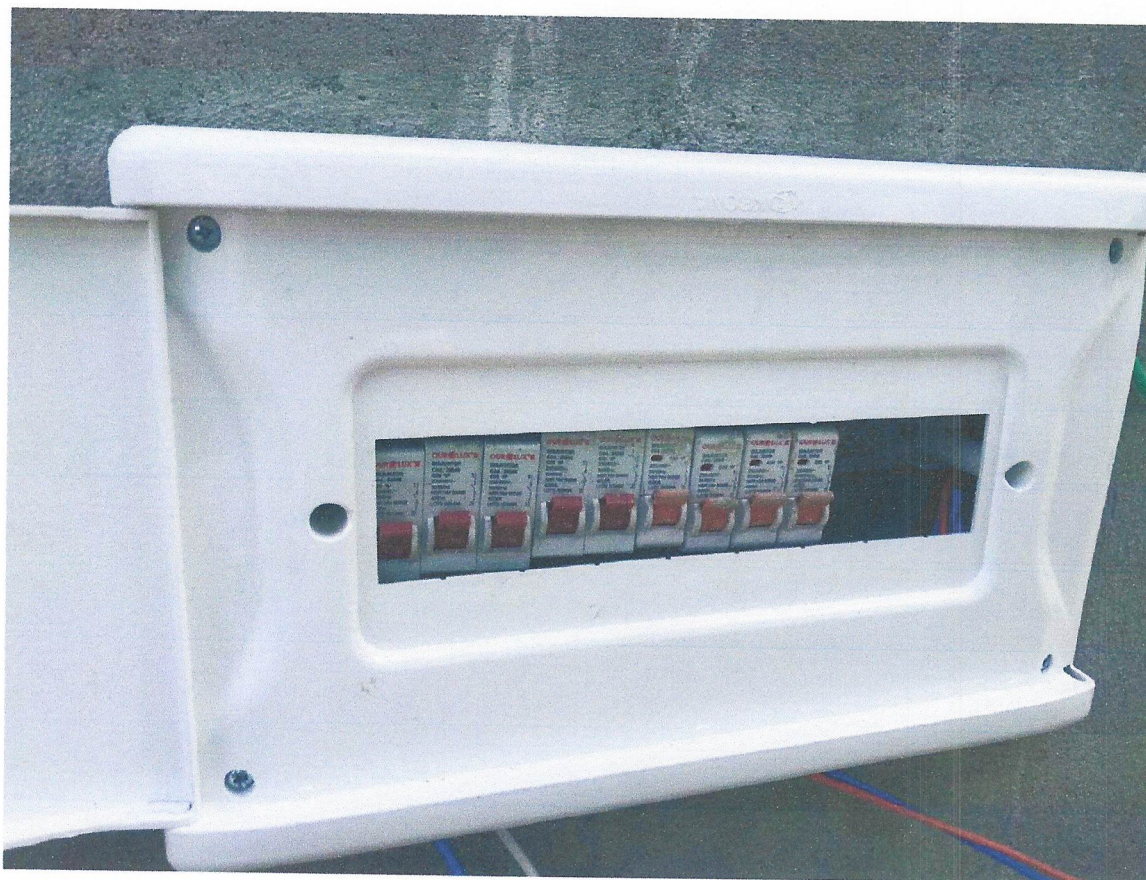
Foto 09 – Quadro de distribuição de sobrepôr, em resina termoplástica, para até 12 disjuntores, com barramento, padrão DIN, exclusive disjuntores
